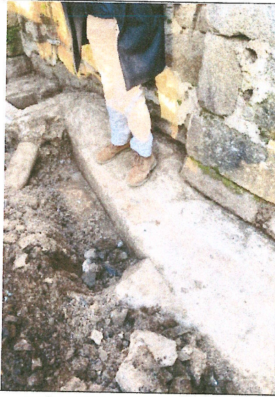
Vue du drain en cours de mise en œuvre et du socle rocheux conservé
