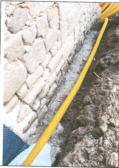
Vue du drain en cours de mise en œuvre et du socle rocheux conservé
