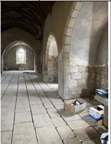
Vues de l'intérieur de l'édifice en cours de piquage des soubassements et des joints ciment compris dégarnissage du dallage en pierre
