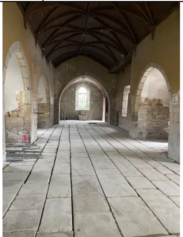
Vues de l'intérieur de l'édifice en cours de piquage des soubassements et des joints ciment compris dégarnissage du dallage en pierre
