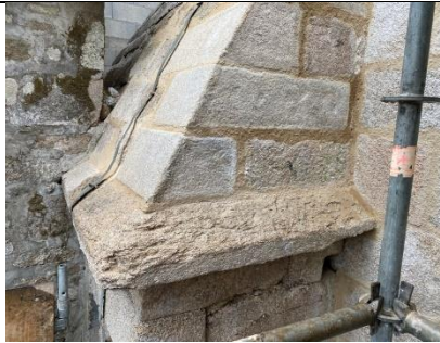
Vue du parement reconstruit coté extérieur.
