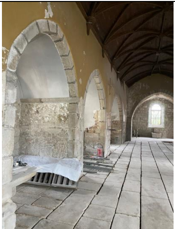
Vues de l'intérieur de l'édifice en cours de piquage des soubassements et des joints ciment compris dégarnissage du dallage en pierre
