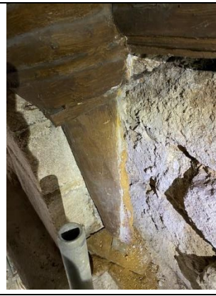
Culot, coté Sud de la nef à purger et conforter au moyen d'une greffe de calage coté mur.
