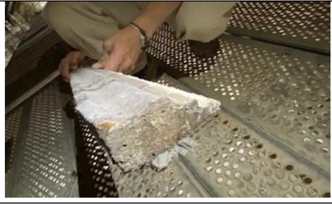
Culot, coté Sud de la nef à purger et conforter au moyen d'une greffe de calage coté mur.
