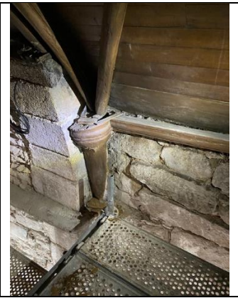
Culot, coté Sud de la nef à purger et conforter au moyen d'une greffe de calage coté mur.
